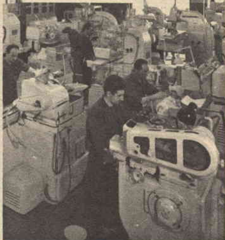
Reparto fabbricazione parti.
